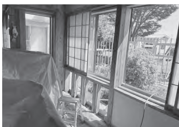
原田家ダイニングの壁修繕
