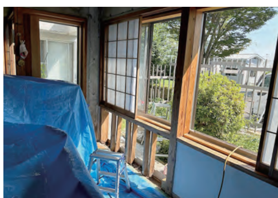
原田家ダイニングの壁修繕
